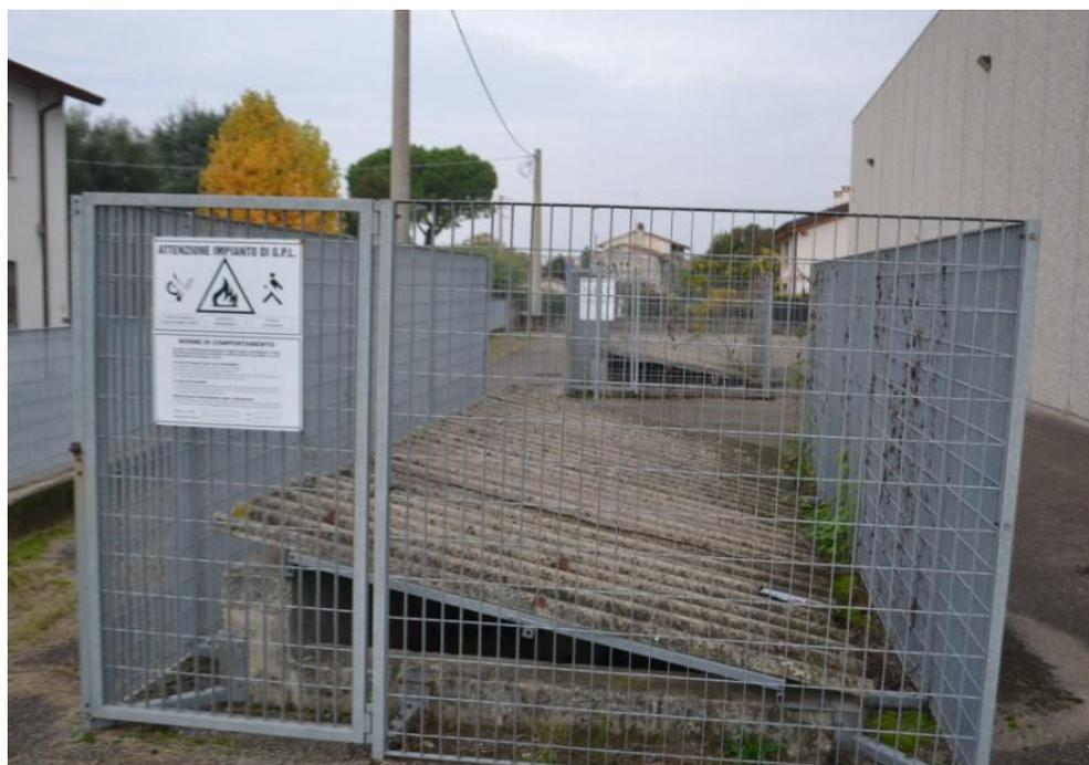
**Sono presenti due serbatoi di gas GPL. Della capacità di 5000 litri cadauna, nel piazzale esterno del capannone.**
