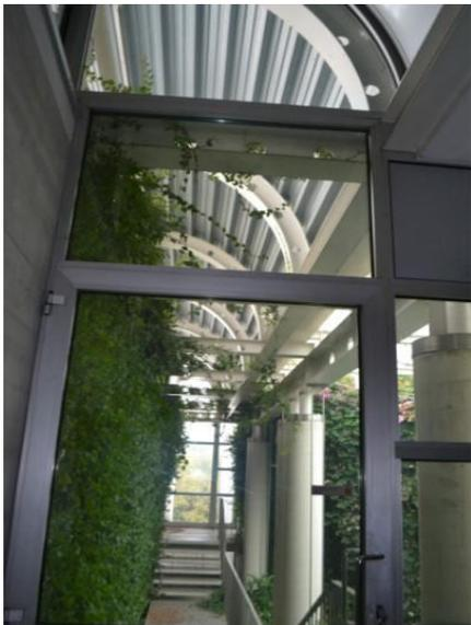
Il **COLLEGAMENTO TRA GLI UFFICI E L'EDIFICIO** adibito a produzione è stato realizzato con domanda di concessione nel 2001. Avviene attraverso due piccoli tunnel a struttura metallica con tamponamenti in vetro e alluminio. Il pavimento interno è in c.l.s. Le aperture illuminanti ed aeranti corrispondono ai requisiti previsti dalle norme igienico sanitarie, sui lati si trovano le uscite di sicurezza per dare continuità alle vie di fuga esistenti.
